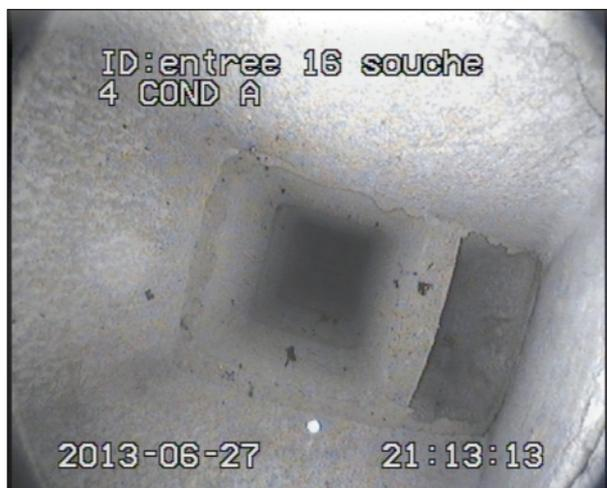
Contrôle des conduits existants par passage caméra
