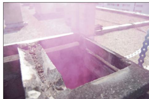
Contrôle de vacuité et de repérage des conduits par test fumigène.
