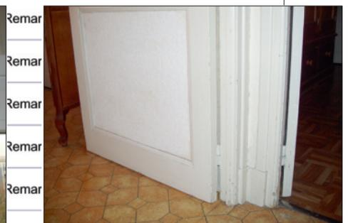
Contrôle visuel du détalonnage de porte
